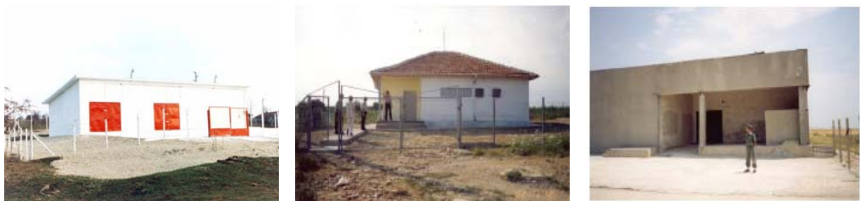
Снимка 6 Ремонтирани складове за съхранение на залежали пестициди
