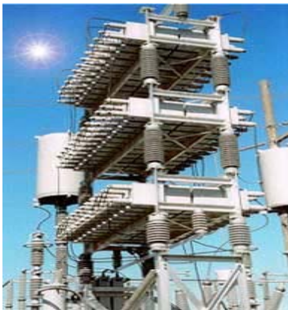
Снимка 10 Кондензаторни батерии
