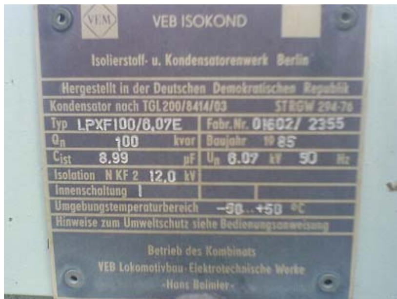
Снимка 6 Фабрична табела на кондензатор съдържащ ПХБ, Градска подстанция
